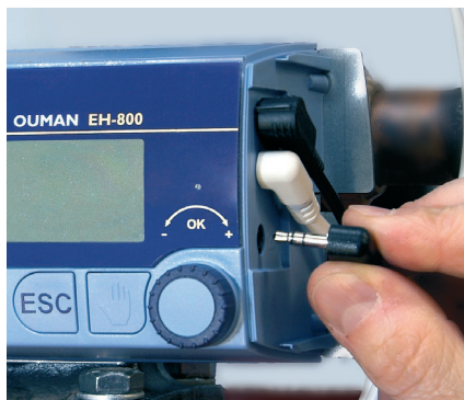
Løsne kontrollhode fra ventilen og sett monteringssett på plass. Trykk EH-800 på plass, koble sensorer, plugg det inn, og enheten er klar for bruk!
